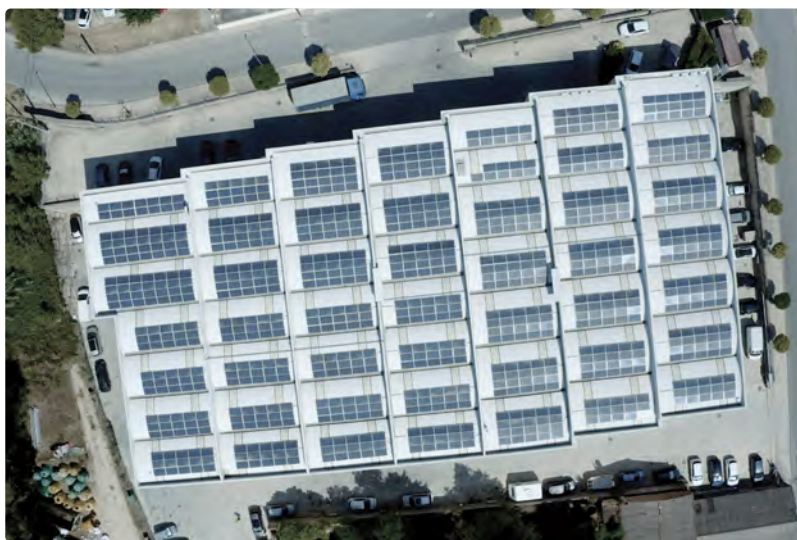
Autoconsumo de energía a través de placas solares.
